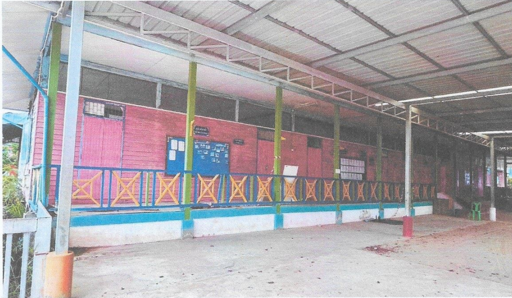
โรงเรียนบ้านหนองหอย อาคารไม้ชั้นเดียวยกพื้น แบบ ป ๑ ข .
