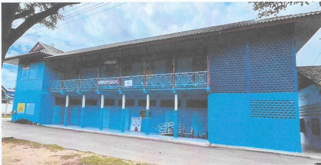
โรงเรียนบ้านหนองหอย อาคารครึ่งตึกครึ่งไม้ ๒ ชั้น แบบ ๐๑๗
